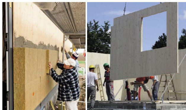
Ukázka prefabrikovaných CLT panelů (Novatop)
