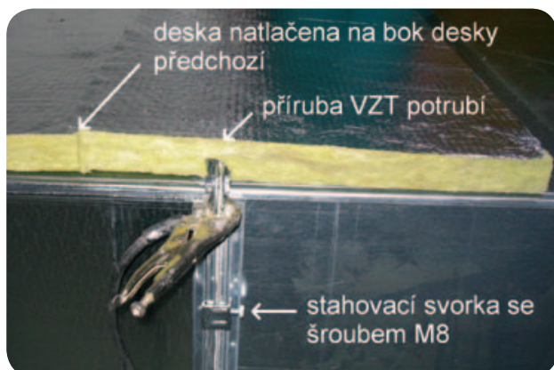
Obr. 26 Spoje izolačních desek leží mimo příruby VZT potrubí.
