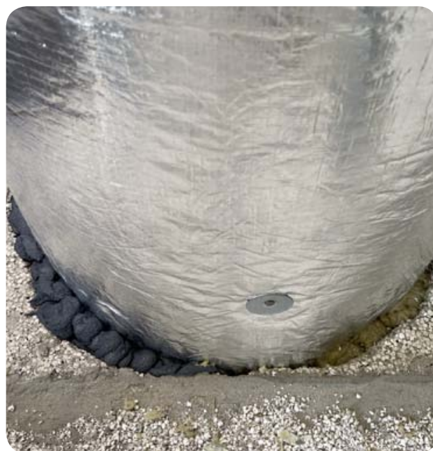
Obr. 36 Prostup bezpečnostním blokem (3i-isolete).
