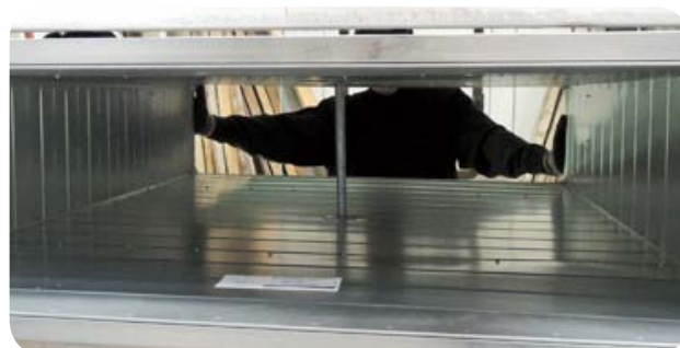
Obr. 63 Vyztužení segmentu potrubí uprostřed rozpětí.
