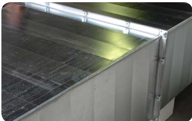
Obr. 18 Příruby zajištěné stahovacími svorkami.
