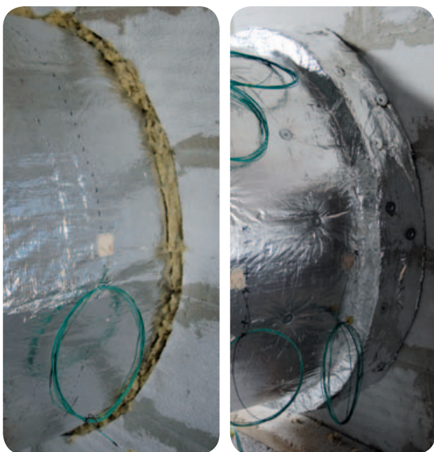
Obr. 35 Požární ucpávka řešená izolačním límcem – před provedením izolačního límce z druhé vrstvy lamelové rohože se nejdříve docpe meziprostor mezi izolovaným potrubím a požárně dělicí konstrukcí.
