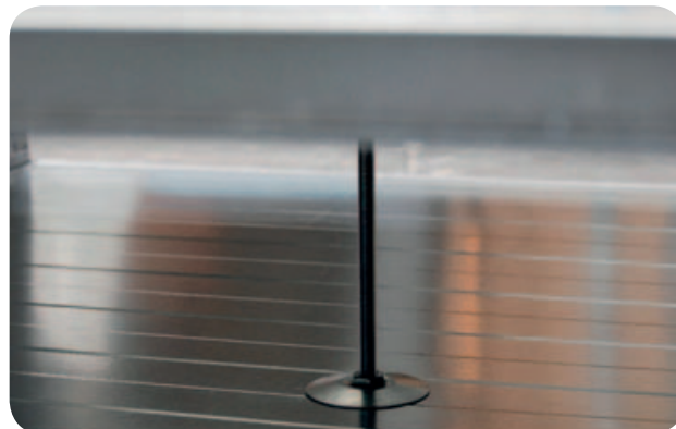
Obr. 9 Potrubí typu B může vyžadovat v každém segmentu vnitřní výztuhu pro zajištění celistvosti potrubí.
