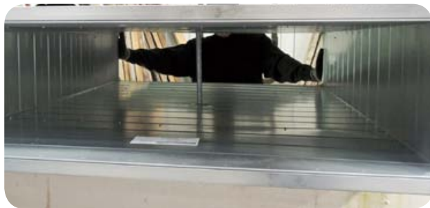
Obr. 37 Vyztužení segmentu svislého potrubí uprostřed rozpětí.
