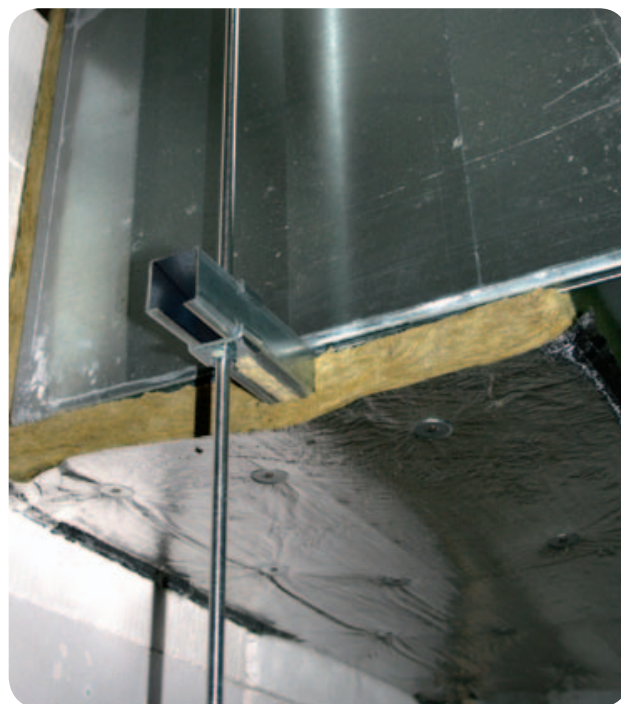
Obr. 22 Izolování nosné systémové lišty výšky 40 mm izolací tloušťky 40 mm.
