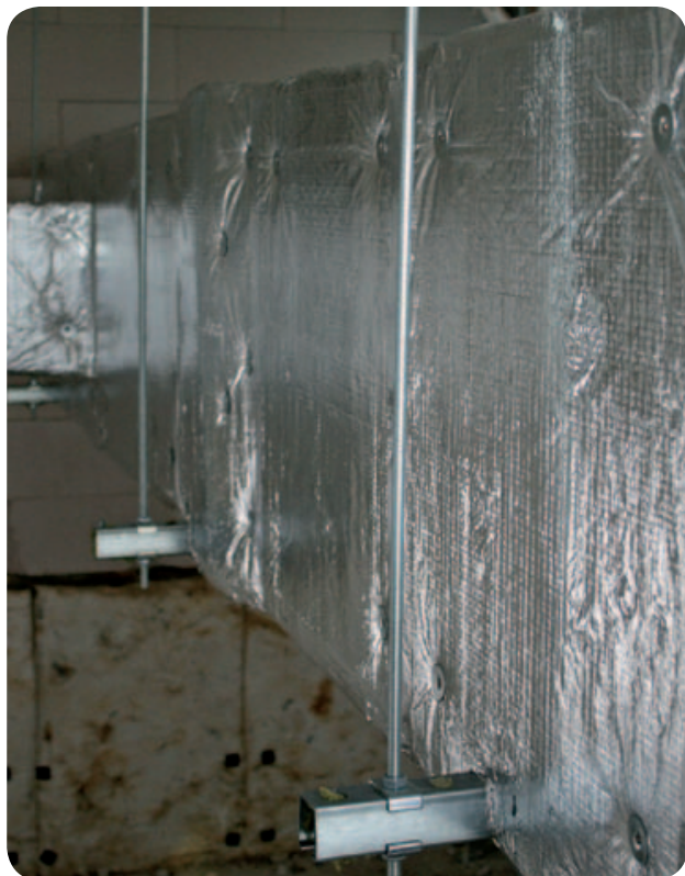
Obr. 21 Zavěšení potrubí závitovými tyčemi a nosnými profily. Na obrázku jsou závitové tyče umístěny vně izolace (část nosného profilu vyčnívajícího z izolace se v tomto případě neizoluje, pouze se vyplňuje odřezky na tloušťku izolace).
