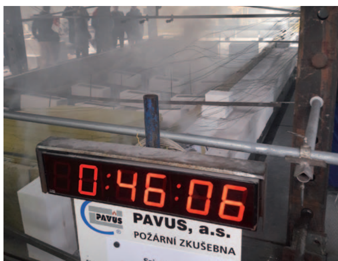
Obr. 10 Akustické ploché střeše Isover ROOF ACOUSTIC byly klasifikovány s požární odolností REI 45 DPI pro celovatovou izolaci MW. Foto požární zkoušky na začátku a ve 46 minutě. Střešní plášť je zcela funkční.
