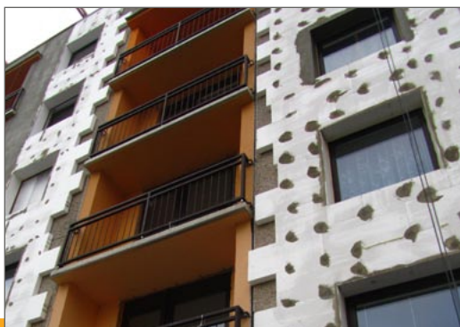
Ukáзка aplikace výrobku Isover EPS 70 F
