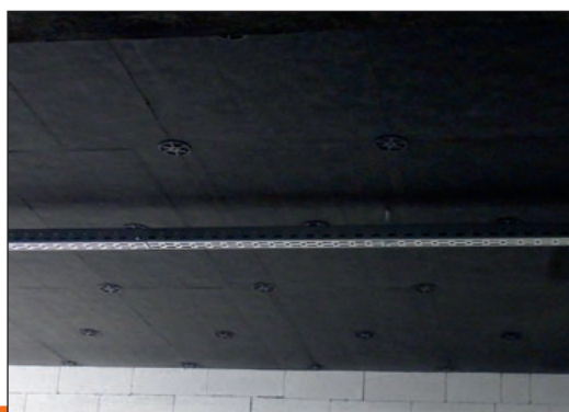
Ukázka aplikace výrobku Isover AKUSTIC SSP 2
