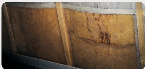
Poškození způsobené zabudováním vlhkého dřeva
