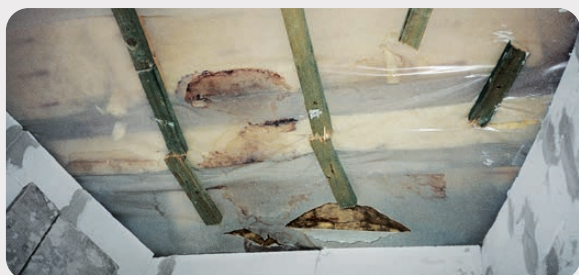
Poškození způsobené zkondenzovanou vodou
