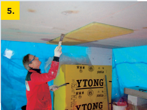
Přitlačení desky a odstranění přebytečného lepidla
