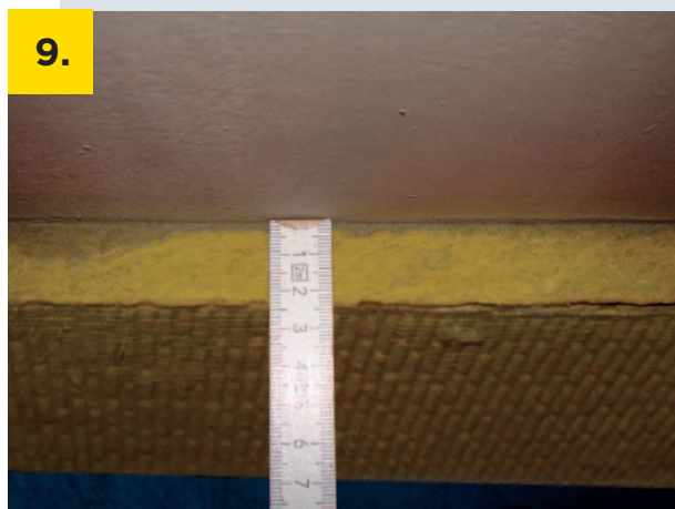
Kontrola tloušťky systému, deska 20 mm, lepidlo 3-4 mm
