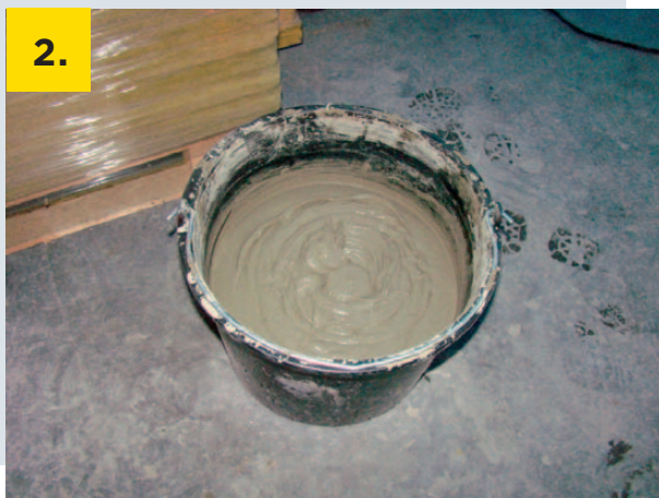
Příprava lepidla Dexaflamm B
