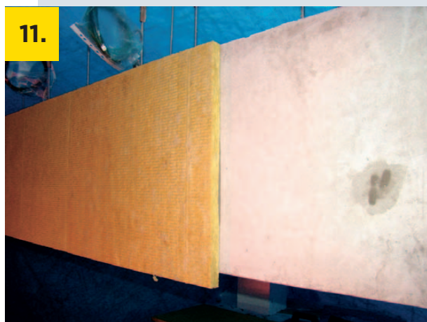
U nosníku se nejprve nalepí boky
