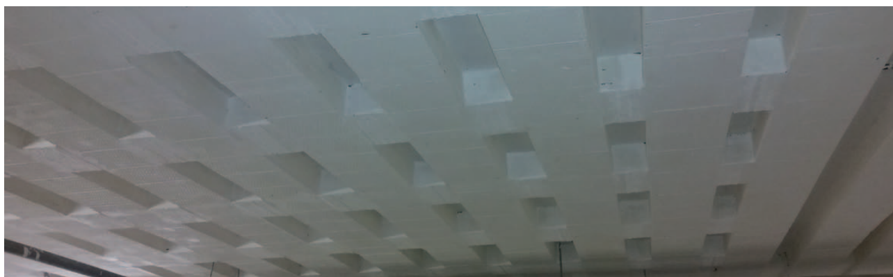
Obr. 21 Konečný vzhled s povrchovou úpravou bílým nátěrem
