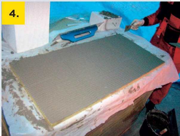
Rozetření lepidla zubovým hladítkem po celé ploše desky
