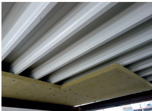
Obr. 9 Systém ISOVER FireProtect® pro ochranu střech z trapézových plechů se vyznačuje nejen nízkou hmotností a malou stavební výškou, ale i přímou montáží obkladu na trapézový plech bez pomocné nosné konstrukce
