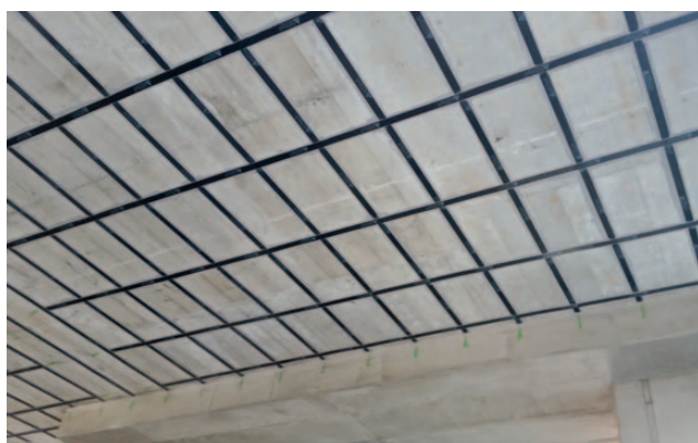
Obr. 19 Uhlíkové lamely před ochranou
