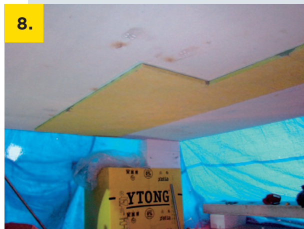
Lepení dalších desek, které se bokem přitlačují k již nalepeným deskám (boky se nelepí)
