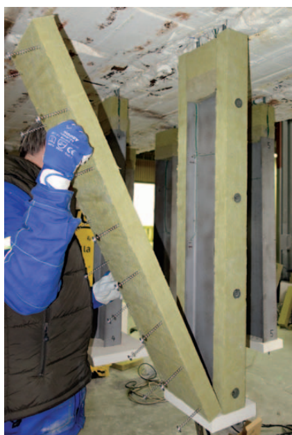
Obr. 5 Obě metody kotvení lze také kombinovat – důležité je pouze dodržet rozestupy (mezi trny 300 mm a mezi vruty 150 mm)
