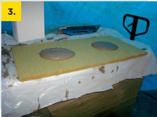
Nanesení přiměřeného množství lepidla Dexaflamm B na desku
