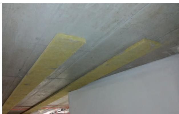
Obr. 20 Rozpracovaný obklad ORDEXAL® KARBON ALB bez povrchové úpravy
