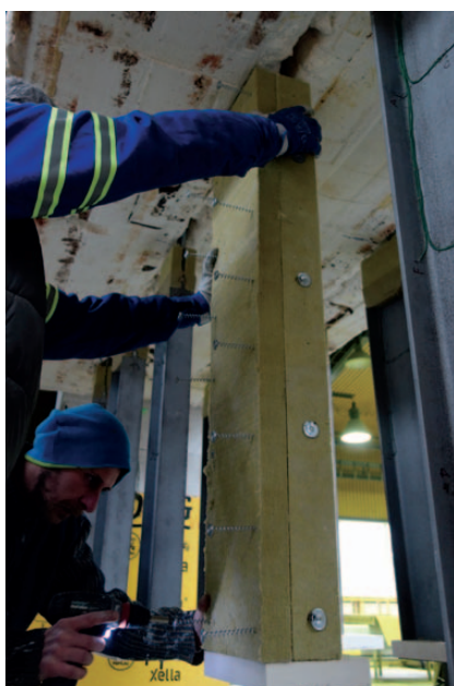
Obr. 5 Obě metody kotvení lze také kombinovat – důležité je pouze dodržet rozestupy (mezi trny 300 mm a mezi vruty 150 mm)
