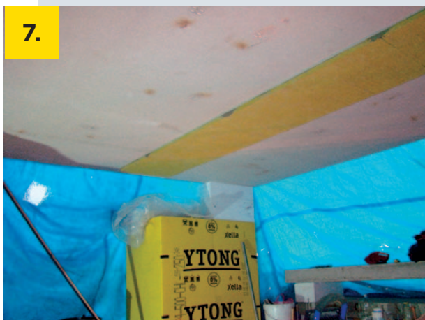
Nalepení první řady desek – kontrola přímosti pásu
