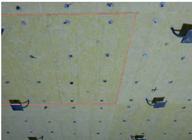
Obr. 13 Pohled na dokončený obklad trapézového plechu, červeně zvýrazněný rozměr 1 x 1,2 m použité desky ISOVER FireProtect® 150
