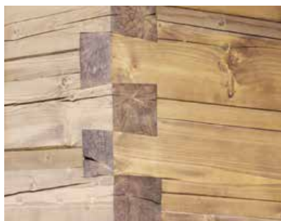
Roubenka tl. 200 mm > nahrazuje 40 mm tepelné izolace
