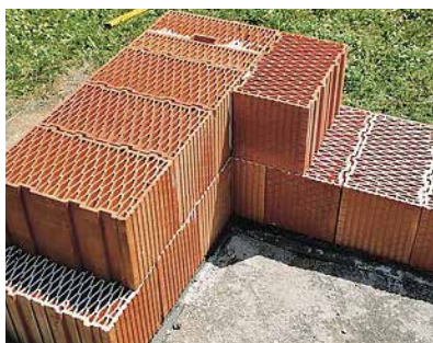
Therm bloky 450 mm > nahrazuje 100 mm tepelné izolace
