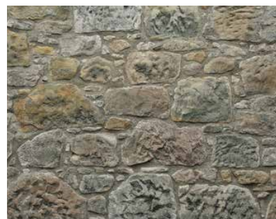
Kamenné zdivo 450 mm > nahrazuje 5 mm tepelné izolace
