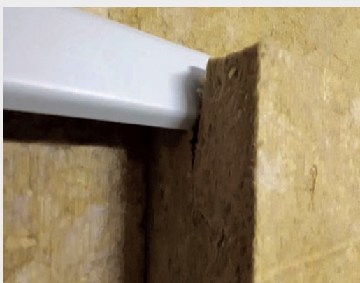
Zářez do izolace pro uchycení do nosu kazety, hloubka zářezu 40–90 mm.
