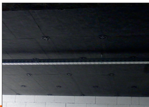
Ukázka aplikace výrobku ISOVER Akustic SSP 2
