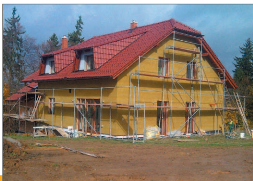
Die Beispielapplikation des ISOVER TF Profi
