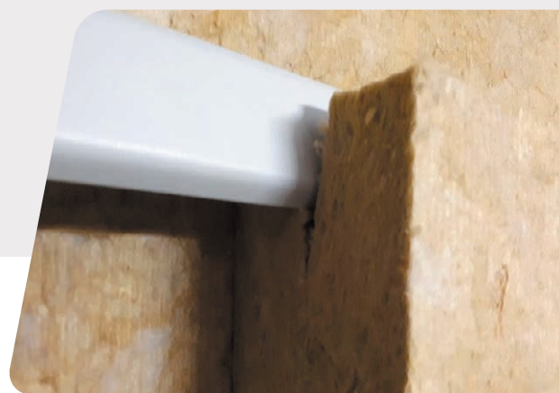
Zářez do izolace pro uchycení do nosu kazety, hloubka zářezu 40–90 mm
