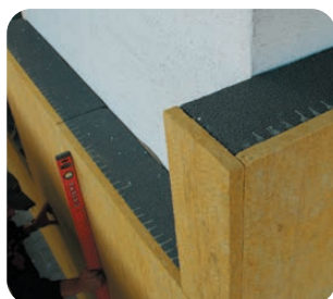
Detail nadpraží pro okno se špaletou šíře menší než 80 mm vyhovující ISO 13785-1 a ISO 13785-2
