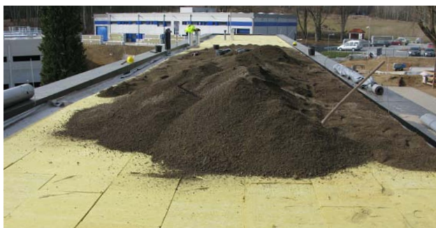
Rozprostření substrátu při realizaci, nutno počítat i s takovýmto dočasným lokálním přetížením, foto: ACRE
