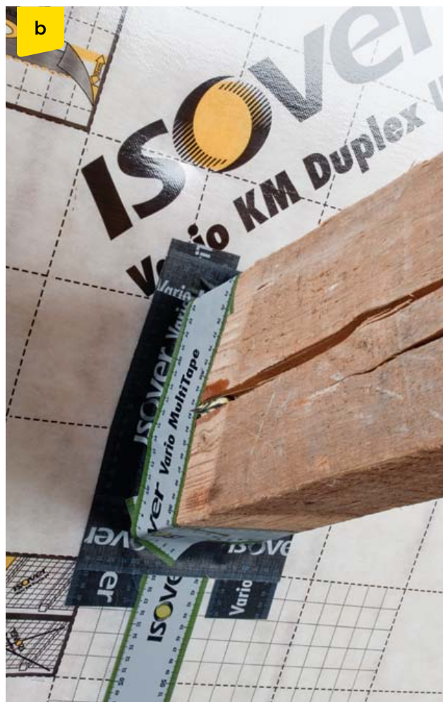
b) u popraskaných trámů ve staré stavbě
