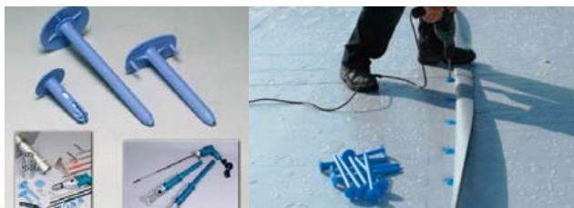
Příklad kotvení fólie hydroizolace teleskopickými kotvami.
