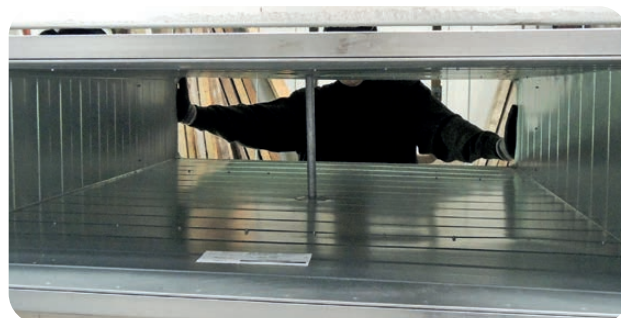
Obr. 60 Vyztužení segmentu potrubí uprostřed rozpětí.
