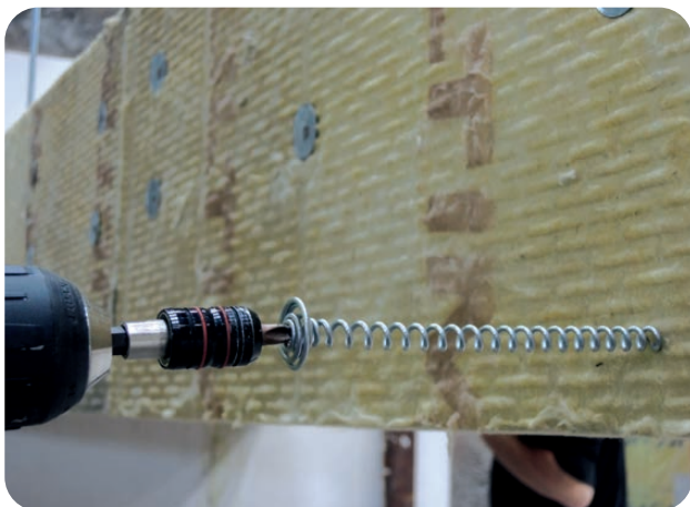
Obr. 65 Rohové styky desek jsou spojeny požárními vruty Fire Screw.
