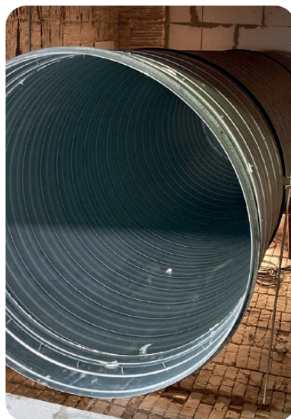
Obr. 32 Pohled na spiro potrubí spojovaného vsuvkami, oba konce vsuvky jsou opatřeny intumescentním požárním tmelem.
