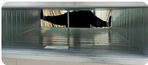
Obr. 37 Vyztužení segmentu svislého potrubí uprostřed rozpětí.
