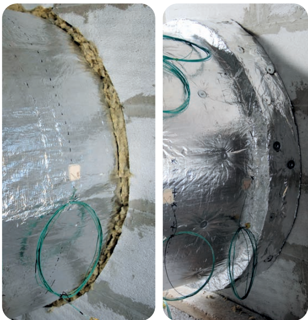
Obr. 35 Požární ucpávka řešená izolačním límcem – před provedením izolačního límce z druhé vrstvy lamelové rohože se nejdříve vycpe meziprostor mezi izolovaným potrubím a požárně dělící konstrukcí.
