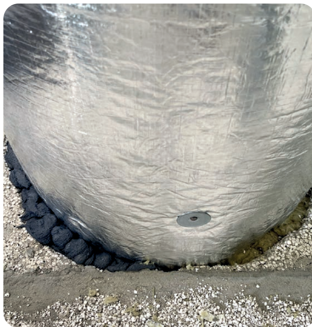
Obr. 36 Prostup bezpečnostním blokem (3i-isoleet).
