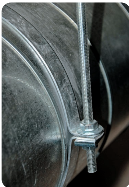
Obr. 31 Detail dvoudílné objímky pro zavěšení kruhového potrubí.
