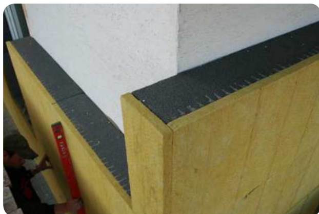
Příklad řešení detailu vazby rohu pomocí rohové desky Isover Twinner.
