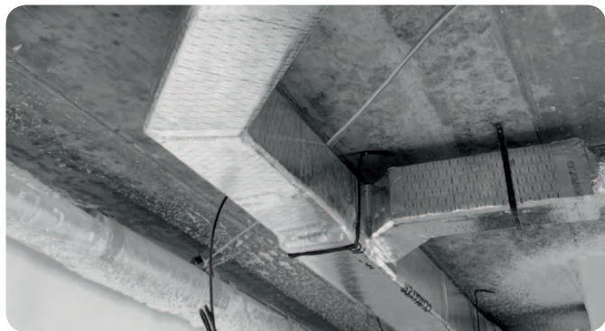
Instalace potrubí do bytových jednotek, bez nutnosti použití tlumiče hluku.
