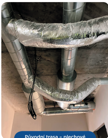
Původní trasa – plechové potrubí s tlumičem hluku
