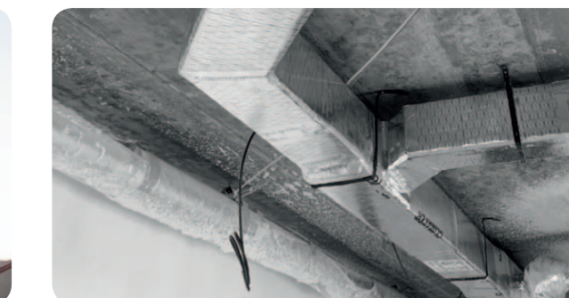
Instalace potrubí do bytových jednotek, bez nutnosti použití tlumiče hluku.
