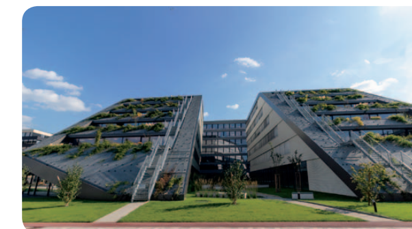
Kancelářské a obchodní prostory DOCK | Praha 8
