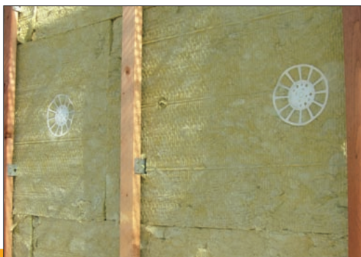
Ukázka aplikace výrobku Isover TOPSIL
