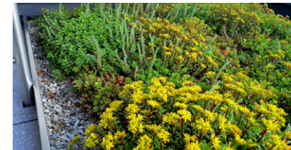
Úsporná střecha Extenzivní - rozchodníky, netřesky
