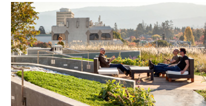
Střešní zahrada Intenzivní - trávnik, keře, stromy
