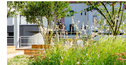
Střešní louka Polointenzivní - suchomilné tráviny
