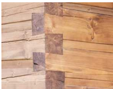
Roubenka tl. 200 mm > nahrazuje 40 mm tepelné izolace
