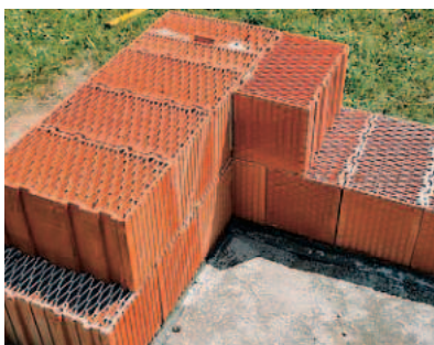
Therm bloky 450 mm > nahrazuje 100 mm tepelné izolace
