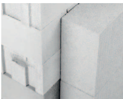
Plynosilikát 450 mm > nahrazuje 120 mm tepelné izolace
