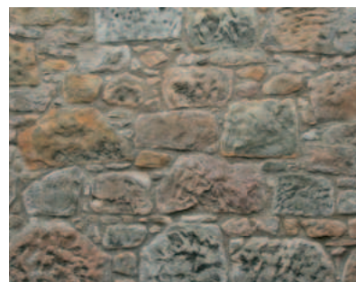
Kamenné zdivo 450 mm > nahrazuje 5 mm tepelné izolace
