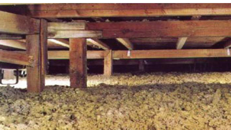
Obr. 5 - Foukaná izolace
