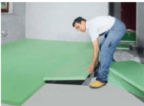
Obr. 19: Izolace podlahy sklepa.
