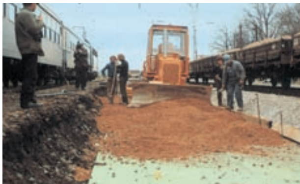
Obr. 8: Ochrana proti mrazu při stavbě kolejového lože s použitím vysoce tlaku odolného Styroduru® C.
