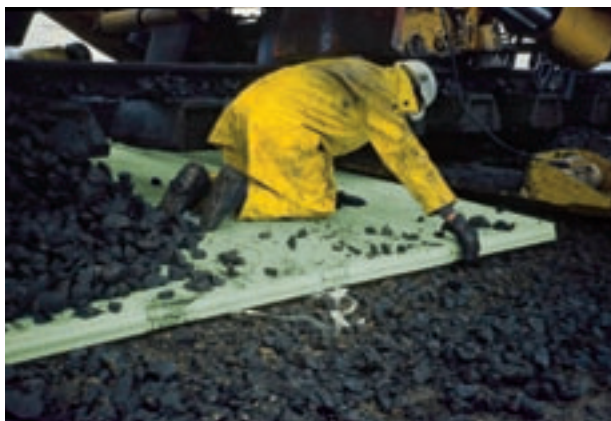
Obr. 9: Pokládka Styroduru® C v kolejovém loži.
