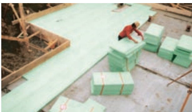
Obr. 4: Pokládka desek Styrodur® C.
