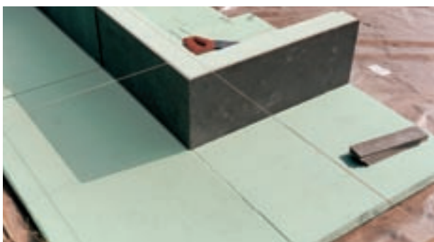
Obr. 3: Izolace základové desky se Styrodurem® C.
