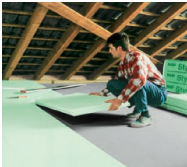
Obr. 10: Izolace střešního prostoru Styrodurem® C.
