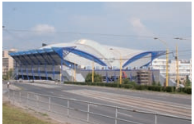
Obr. 17: Referenční projekt: Steel Arena v Košicích (Slovensko). V nové hokejové hale byl pod kluzištěm položen Styrodur® C. Zde se bude v roce 2011 konat mistrovství světa v ledním hokeji.
