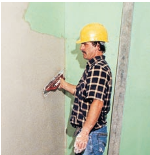
Obr. 32: Roztírání první vrstvy sádrové omítky, síla nátěru 10 mm.
