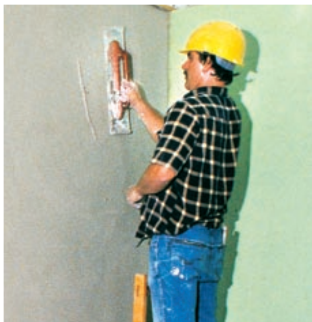
Obr. 34: Roztírání druhé vrstvy omítky – síla nátěru asi 5 mm. Vrstva se nanáší na ještě vlhkou spodní vrstvu.
