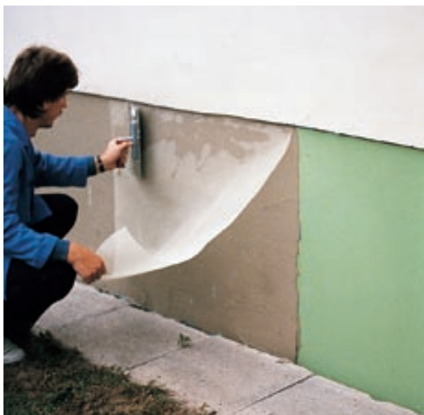
Obr. 29: Vkládání sítě ze skelných vláken do základní omítky izolace soklu.
