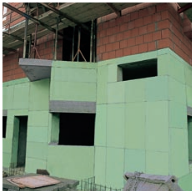
Obr. 25: Velkoplošná izolace přízemí pomocí desek Styrodur® C.
