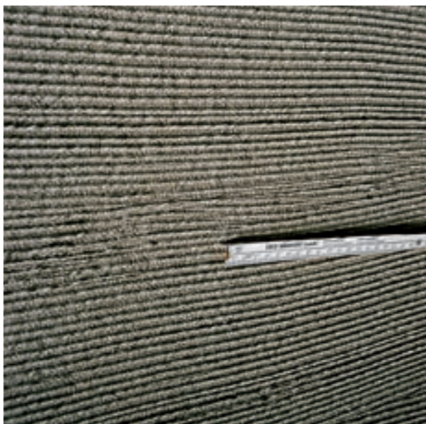
Obr. 24: Vodorovně rozetřený spojovací nátěr na izolaci Styrodur® C.
