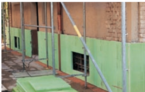
Obr. 17: Dodatečné zateplení soklu Styrodurem® 2800 C.
