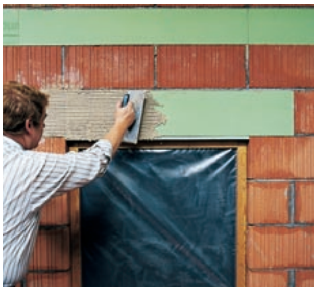
Obr. 20: Nadpraží okna v tepelně izolačním zdivu; vodorovně rozetírání spojovacího nátěru.
