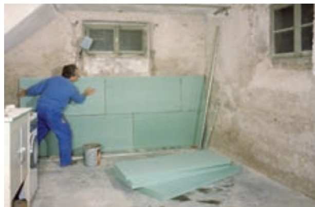
Obr. 20: Na základě svých vlastností je Styrodur® C vhodný i k vnitřní izolaci sklepních prostor.
