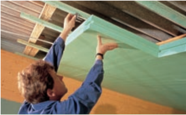
Obr. 10: Montáž samonosného podhledu.
