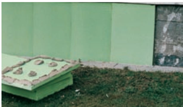
Obr. 14: Sanace staré stavby: Nalepení desek Styrodur® 2800 C bodově.
