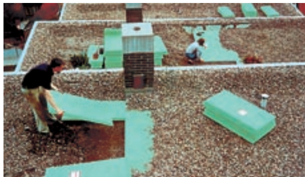
Obr. 5: Uložení izolační vrstvy pod šterkem.
