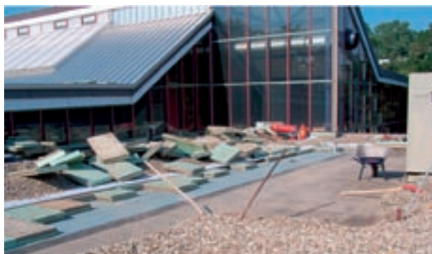
Obr. 1: Sanační opatření s materiálem Styrodur® C.
