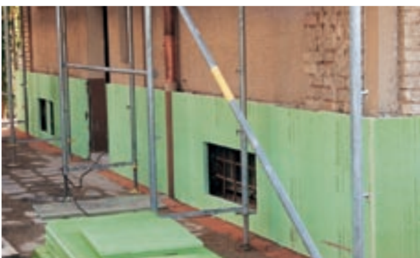
Obr. 12: Dodatečná izolace soklu materiálem Styrodur® 2800 C.
