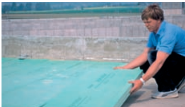
Obr. 4: Uložení izolační vrstvy z materiálu Styrodur® C na střeše.
