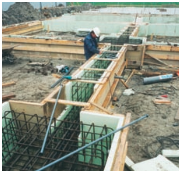
Obr. 15: Bednění se Styrodurem® C.
