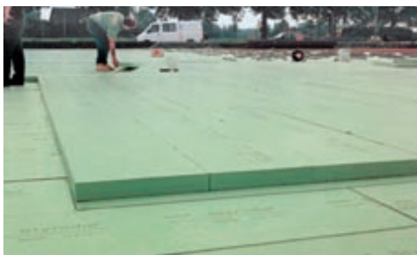
Obr. 29: Pokládka desek Styroduru® C při stavbě pasivního domu.
