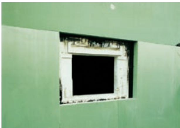
Obr. 4: Izolační opatření s použitím Styroduru® C.
