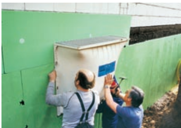
Obr. 3: Izolace suterénu Styrodurem® C.
