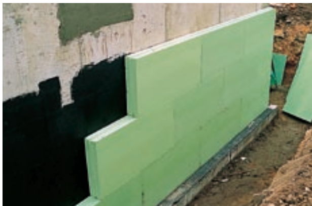
Obr. 5: Kladení desek Styrodur® C na vazbu.
