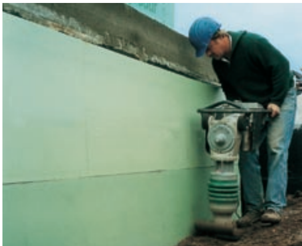
Obr. 26: Zasypávání stavební jámy po vrstvách a mechanické zhutňování.
