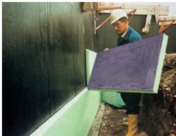
Obr. 6: Osazování desek Styroduru® C na stěnu suterénu.
