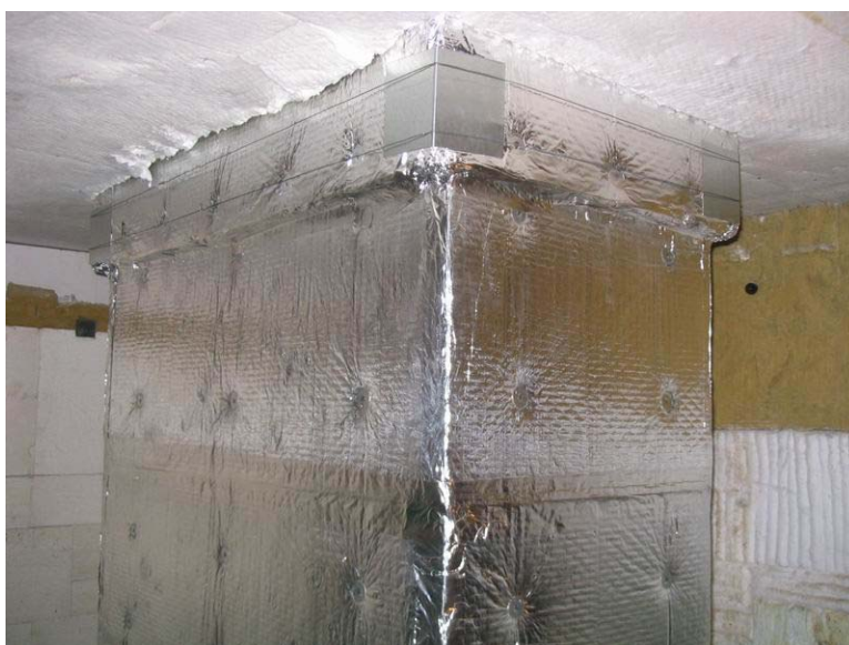
Obr. 25 Požární ucpávka u čtyřhranného potrubí
