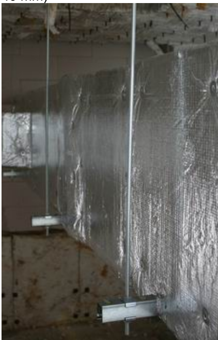
Obr. 18 Zavěšení potrubí pomocí závitových tyčí a nosných lišt. Na obrázku závěsy umístěny vně izolace (část nosné lišty vyčnívající z izolace se v tomto případě neizoluje).
