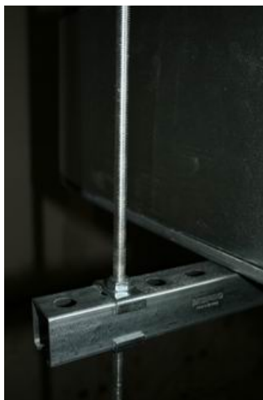
Obr. 9 Detail závěsné konzoly pro zavěšení čtyřhranného potrubí
