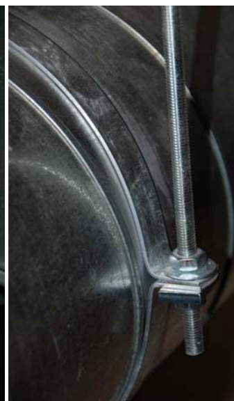
Obr. 10 Detail dvoudílné objímky pro zavěšení kruhového potrubí
