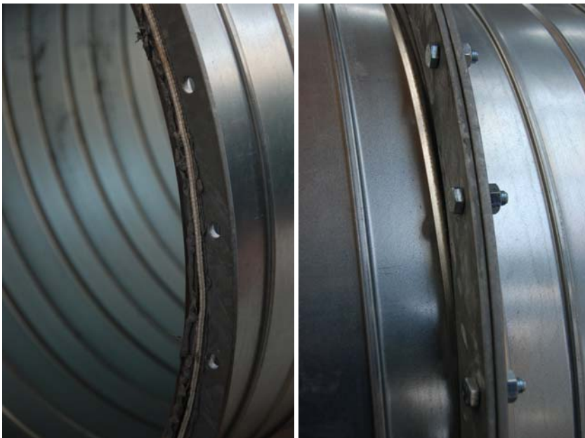
Obr. 7 Izolační šňůry v protipožárním silikonu mezi přírubami kruhového potrubí staženými šrouby
