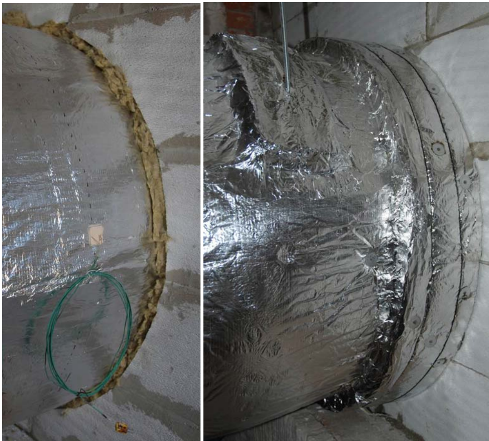
Obr. 27 Před provedením izolační manžety z druhé vrstvy lamelové rohože se nejdříve maximálním možným způsobem docpe meziprostor mezi izolovaným potrubím a požárně dělicí konstrukcí
