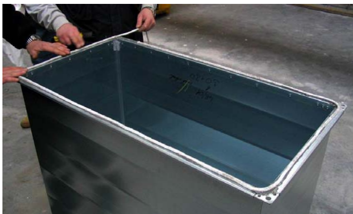
Obr. 4 Vložení těsnící izolační šňůry do protipožárního silikonu mezi příruby pro zajištění vzduchotěsnosti
